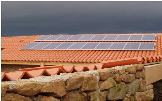
Telhado inclinado com telha lusa
